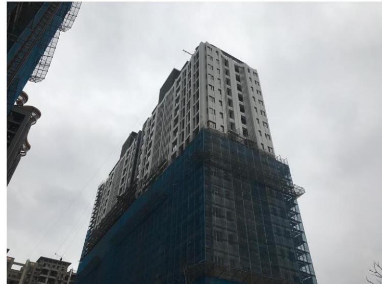
日期： 1/25 施作內容： AB棟第一階段12樓以上拆架
