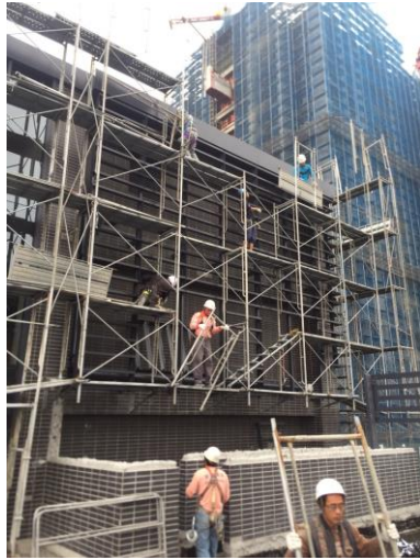
日期： 1/13 施作內容： B棟RF拆架
