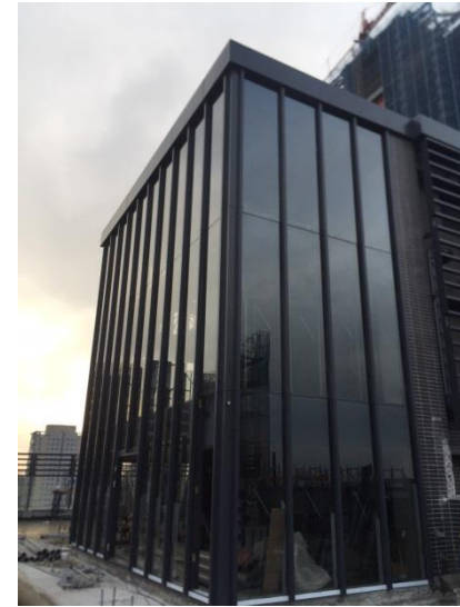
日期： 1/16 施作內容： B棟RF拆架完成
