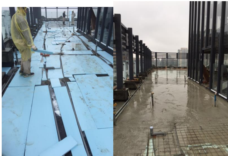
日期： 1/19 施作內容： B棟RF防水隔熱及抗裂施作/1/20壓層澆置
