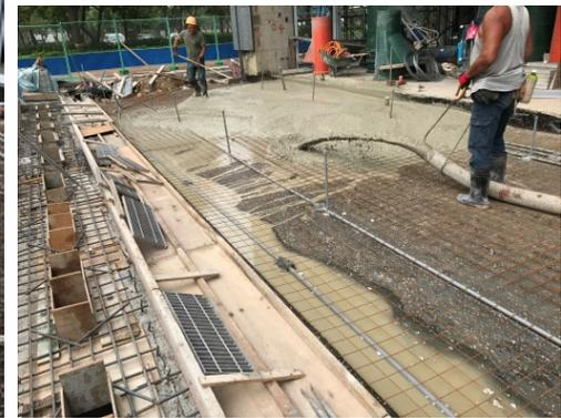
日期： 4/18 施作內容： 1F點焊鋼絲網/壓層澆置
