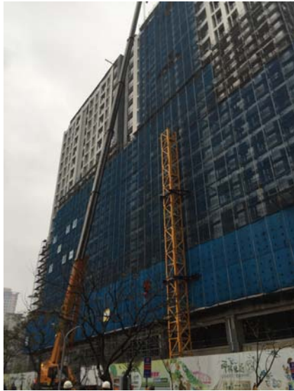
日期： 3/1 施作內容： 塔吊拆除
