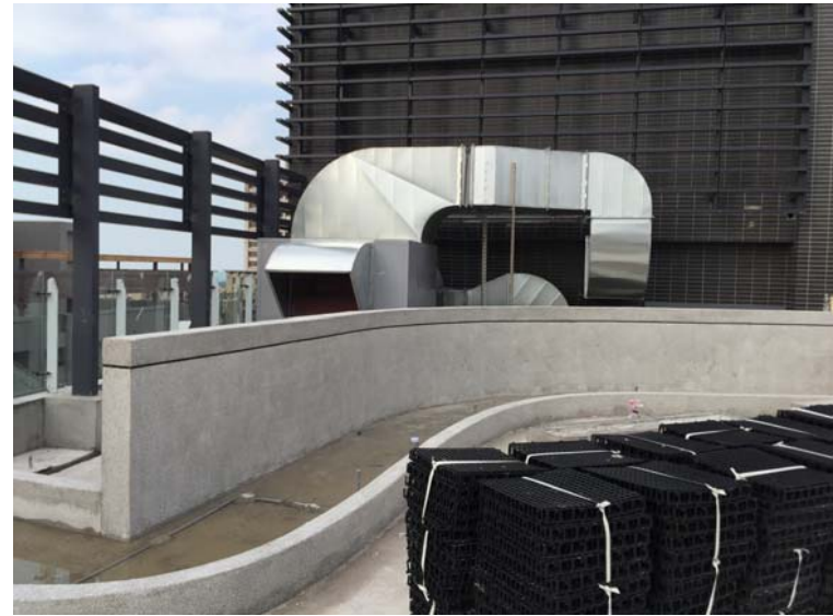
日期： 3/24 施作內容： RF 通風設備安裝
