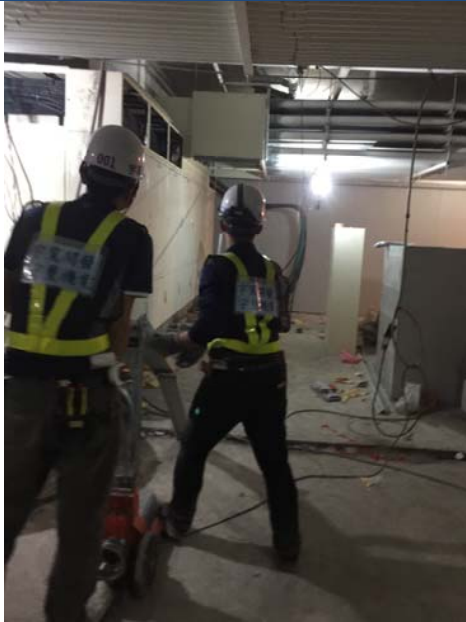
日期： 3/23 施作內容： B1F 幹線拉線
