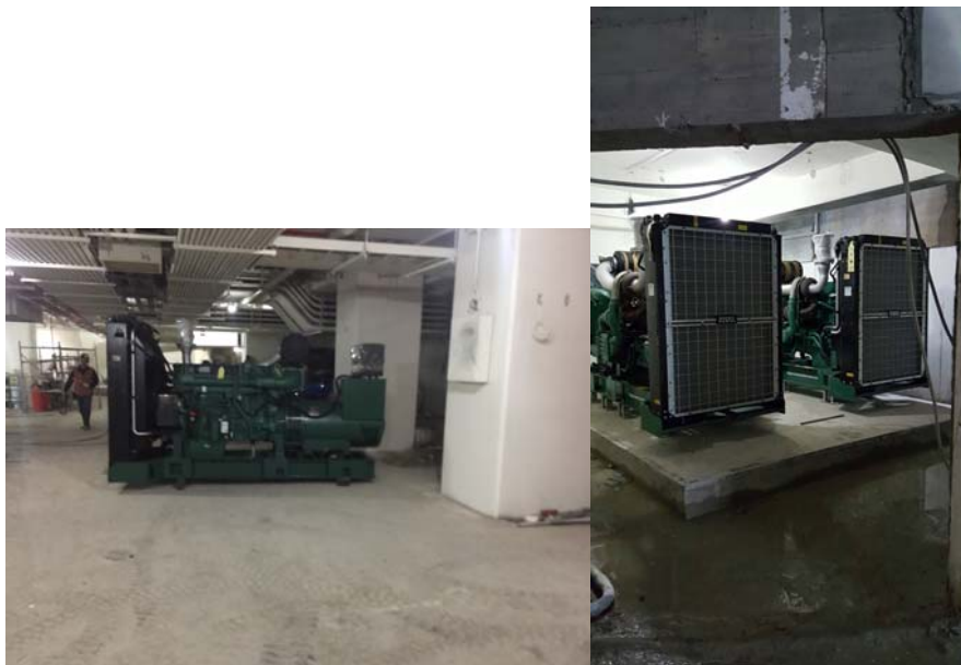
日期： 3/26 施作內容： 發電機配置安裝
