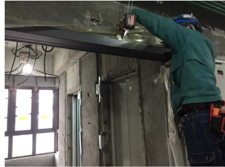
日期： 3/8 施作內容： 梯廳 D3 防火門門框施作
