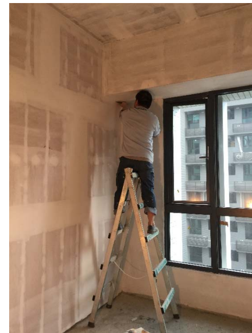
日期： 2/25 施作內容： 室內油漆批土施作
