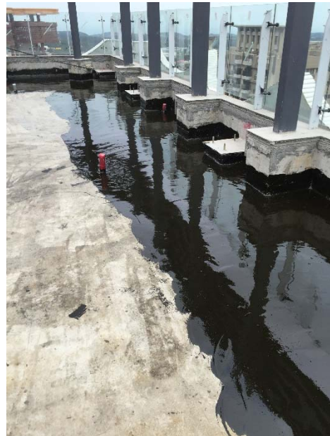
日期： 2/6 施作內容： RF 第二層焦油 PU 施作
