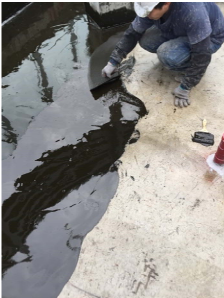
日期： 2/6 施作內容： RF 第二層焦油 PU 施作
