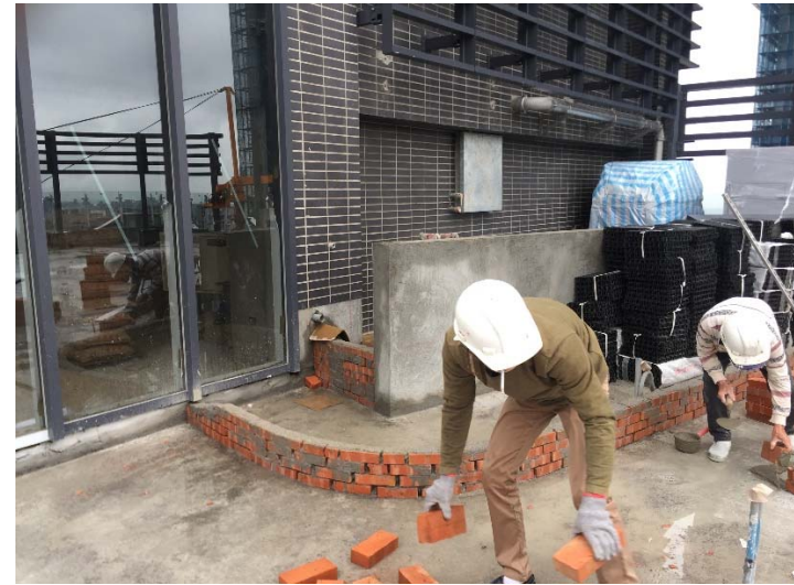
日期： 2/12 施作內容： RF花台施作
