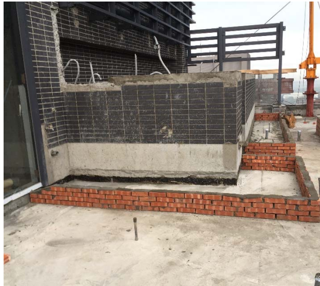
日期： 2/12 施作內容： RF花台施作
