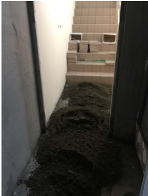
日期： 2/18 施作內容： 1F樓梯間地磚施作
